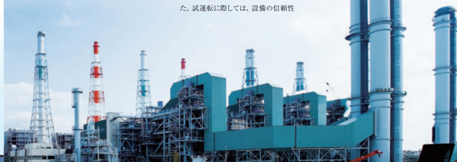
新設堺港発電所
