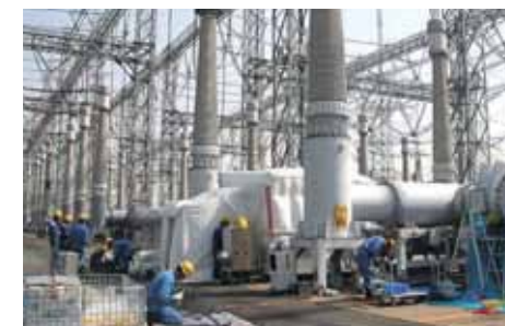
変電所での保守・点検作業
