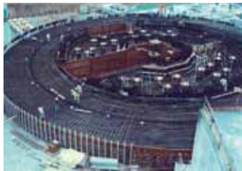
原子炉建屋の基礎工事
