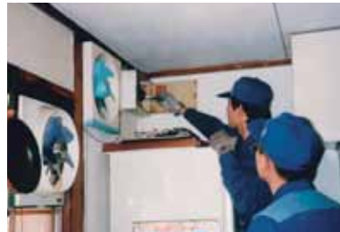
漏電していないかどうかを確認(三国営業所)
