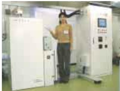
開発した1kW級SOFC発電システム
