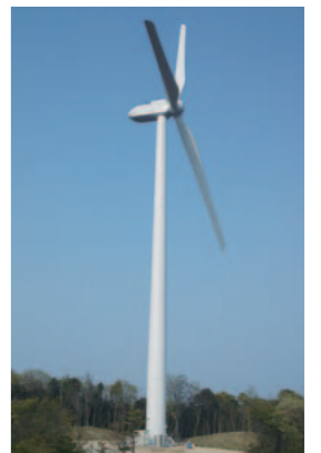
淡路風力発電所
