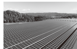
けいはんな太陽光発電所
