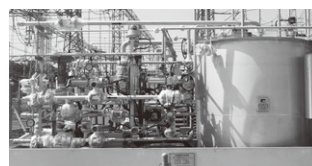
移動式溶剤洗浄処理のための装置
