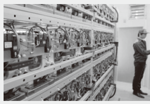
実証試験に使用している蓄電池
