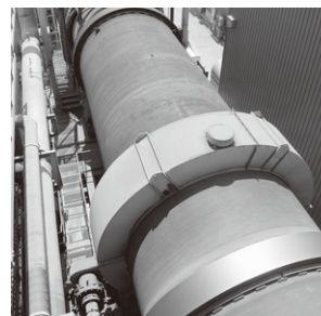
熱処理設備 「ロータリーキルン」
