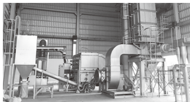
連続炭化炉（籾殻を炭化し、くん炭を生産。発生する温風は籾の乾燥に利用）
