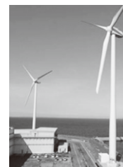
田原4区風力発電所
