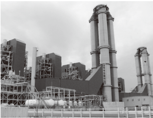
姫路第二発電所
