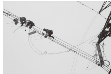
復旧作業は地上約70mの高所でおこなわれた
