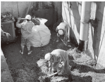
蓄積した漂流物を手作業で取り除く
