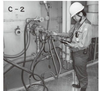
ボイラ周りの点検の様子
