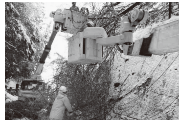
雪のなかでの倒木除去作業
