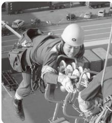
架空送電線の保守業務を担当しています。お客さまへ電気を安全・安定供給するため、設備の巡視・点検や補修作業などをおこなっています。定期的に鉄塔や電力線を点検し、錆などの異常があれば自ら取り替え、設備を健全に維持するほか、送電線事故が発生したときは、その場所や原因も確認します。安全最優先のもと、お客さまへ確実に電気をお届けすることが、私の使命と責任です。
