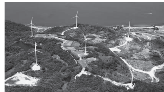
淡路風力発電所
