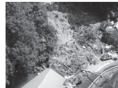
土砂崩れによる被害
