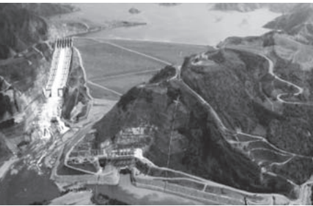
サンロケ水力発電所(フィリピン)
