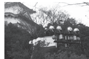
姫路城の照明器具の清掃
