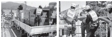
中圧ポンプを設置し、蒸気発生器への給水を確保
