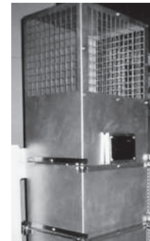
静的触媒式水素再結合装置（イメージ）
