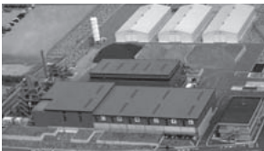
浄化プラント全景
