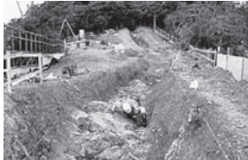
トレンチ調査
