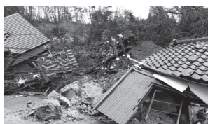
建物が倒壊している様子
