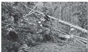
電柱および樹木の倒壊により寸断された道路
