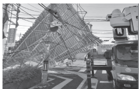
強風により飛来物が電柱に引っかかる様子
