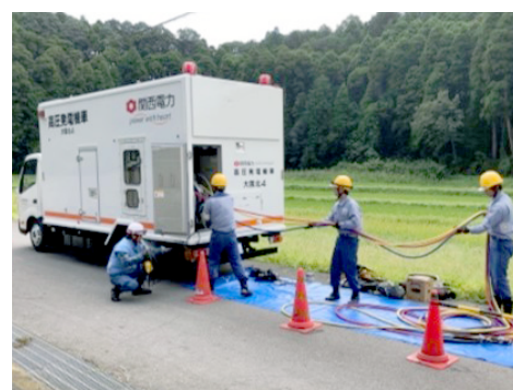
応急送電の準備作業(千葉県東金市 2019年9月 台風15号)
