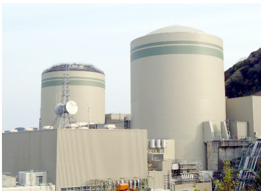
高浜発電所1、2号機 原子炉格納容器上部造へい設置工事
