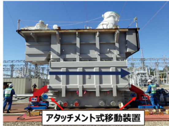
アタッチメント式移動装置による新工法
