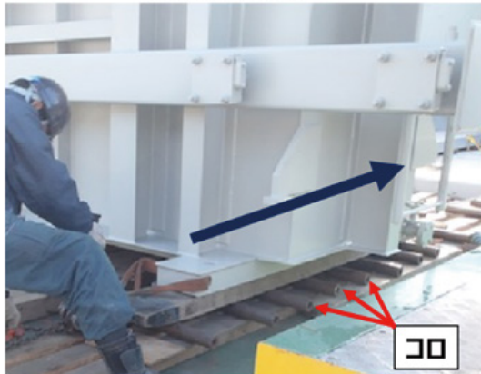
コロ曳き工法
