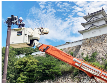
高所作業車を活用した文化財や街路灯等の清掃・点検
