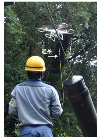
ドローンが道糸をつけて離陸する様子
