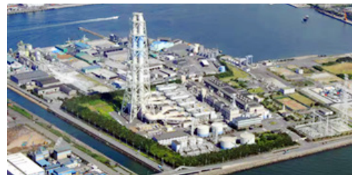
姫路第一発電所
