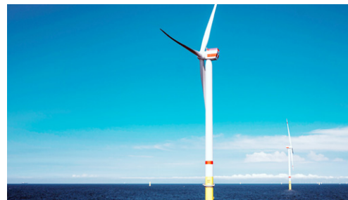
ボークムリフグルンド3洋上風力発電事業
