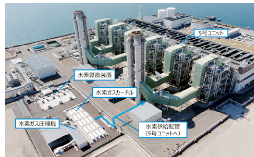
姫路第二発電所
