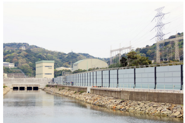
津波防護対策(防潮堤)
