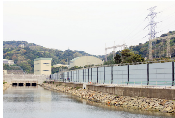
津波防護対策(防潮堤)
