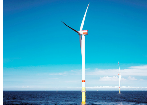
ボークムリフグルンド3洋上風力発電事業
