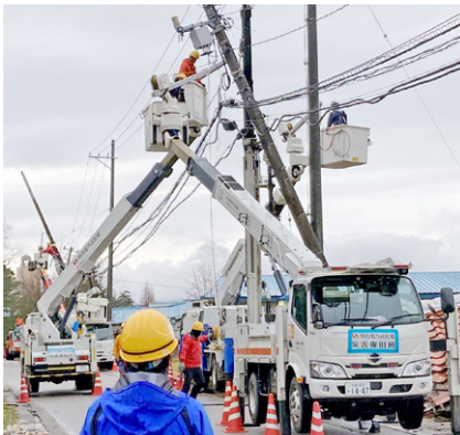
停電復旧作業の様子
