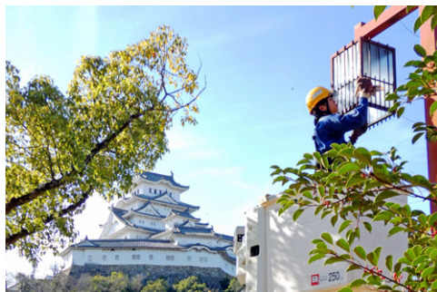
高所作業車を活用した姫路城周辺の街路灯清掃
