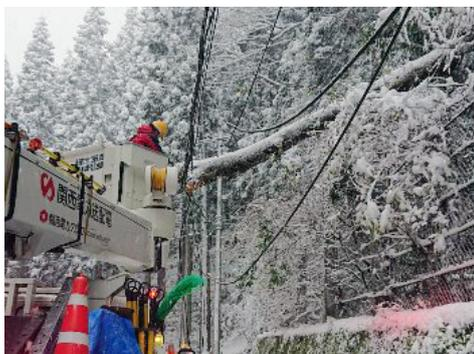
倒木により断線した電線の復旧
