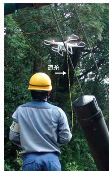
ドローンが道糸をつけて離陸の様子
