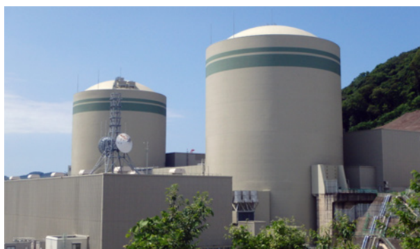
高浜発電所1・2号機 原子炉格納容器上部遮へい設置工事
