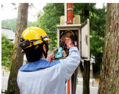
高野山の電気設備点検
