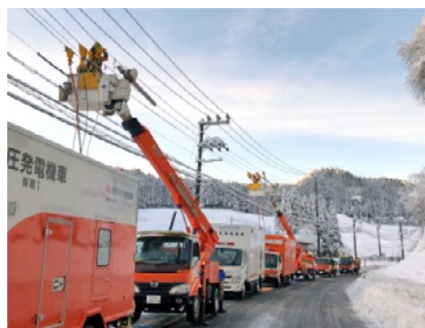
発電機車による応急送電(2020年12月)
