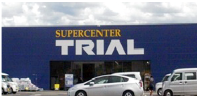
トライアルカンパニー様の屋号と太陽光パネル
