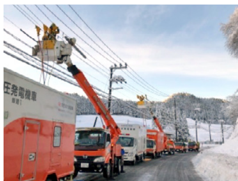
発電機車による応急送電（2020年12月）
