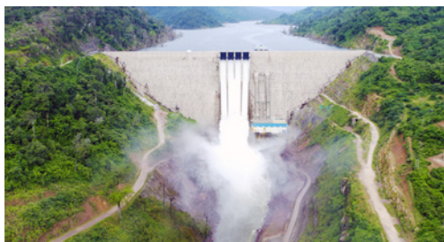
ラオス・ナムニアップ1水力発電所
