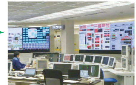
最新のデジタル式操作・監視盤を採用。
