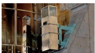
静的触媒式水素再結合装置
