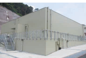
緊急時対策所
