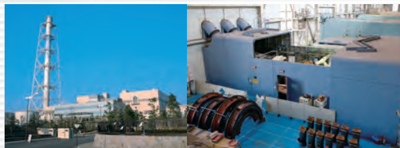
小型ガスタービンの設置(姫路第一発電所)
