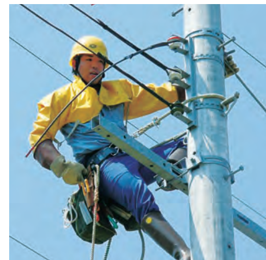
●配電線のメンテナンス
