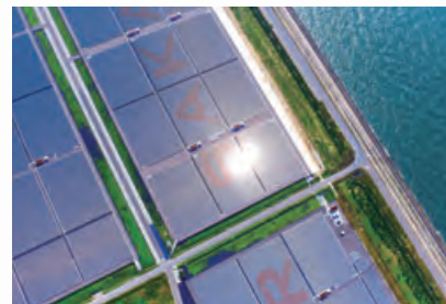
●堺太陽光発電所
