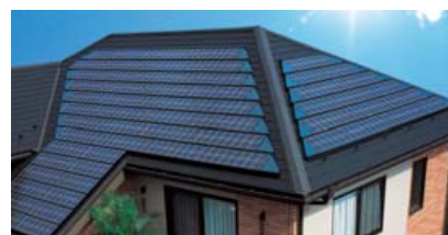
●屋根に設置した太陽電池モジュール
