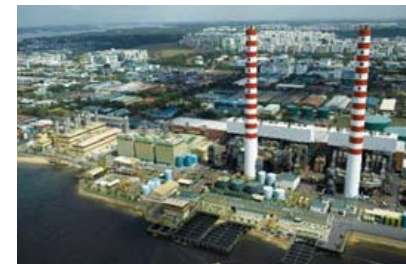
●シンガポールセノコ火力発電所
