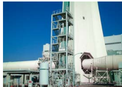
●南港発電所排煙脱炭プラント
