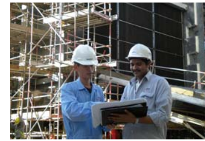
●セノコ発電所でのリパリング工事
