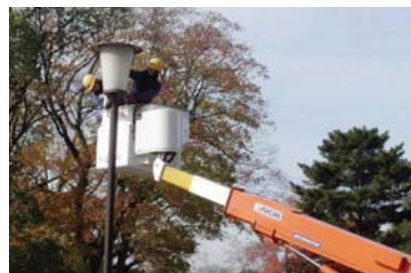
●高所作業車を使って街灯清掃を実施(奈良)
