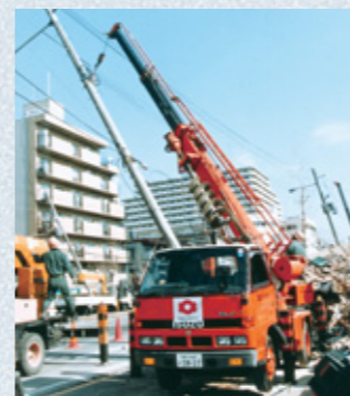
●阪神・淡路大震災時の復旧作業
