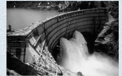
●完成間近の黒部ダム (1963年6月 黒部川第四発電所竣工)
