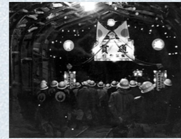
●1958年2月、最大の難工事、関電トンネルが貫通
