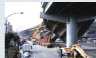
●倒壊した阪神高速道路
