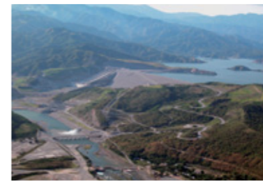
●サンロケ水力発電所
