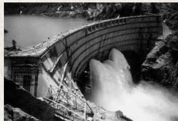
1962年8月、 黒部川第四発電所3号発電機の運転を開始。
