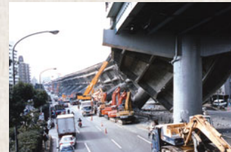
倒壊した阪神高速道路
