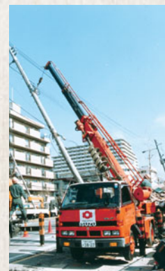
阪神・淡路大震災時の 復旧作業
