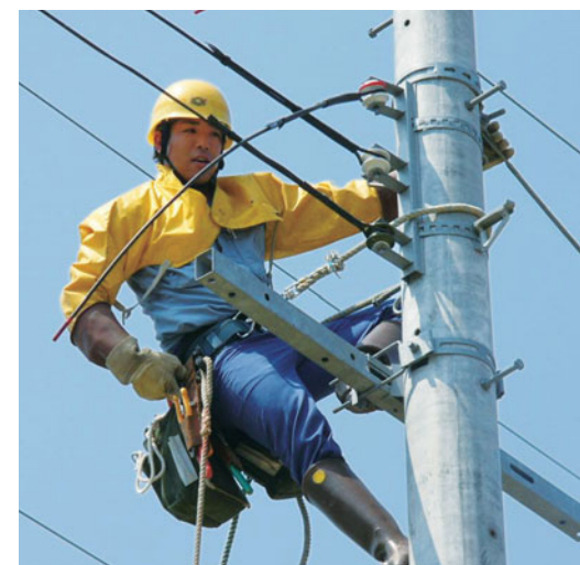
●配電線のメンテナンス
