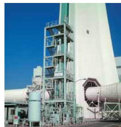
●南港発電所排煙脱炭プラント
