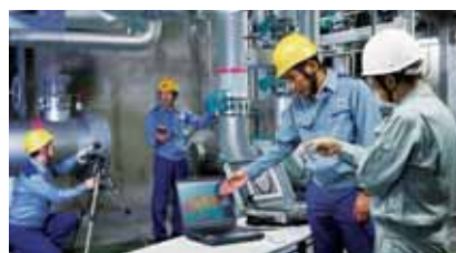
●関西電力によるエネルギー診断
