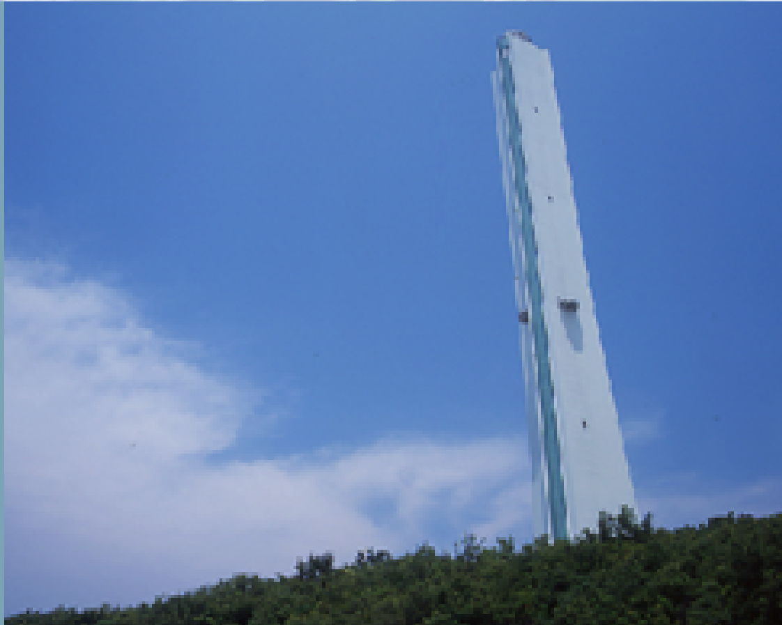
南港発電所 (ISO14001外部認証を取得)
