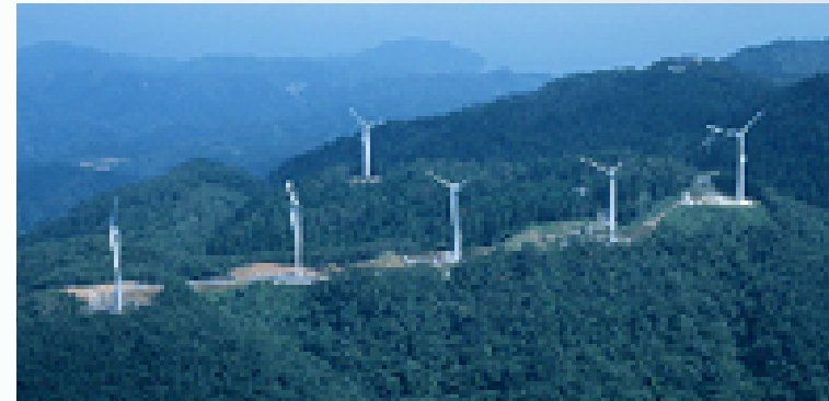
「関西グリーン電力基金」の助成による太鼓山風力発電所 (事業主体：京都府)
