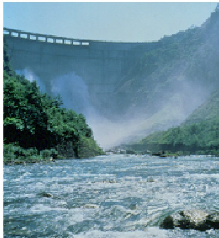
黒部川第四発電所
