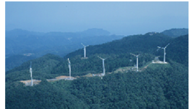
「関西グリーン電力基金」の助成による太鼓山風力発電所 (事業主体・京都府)
