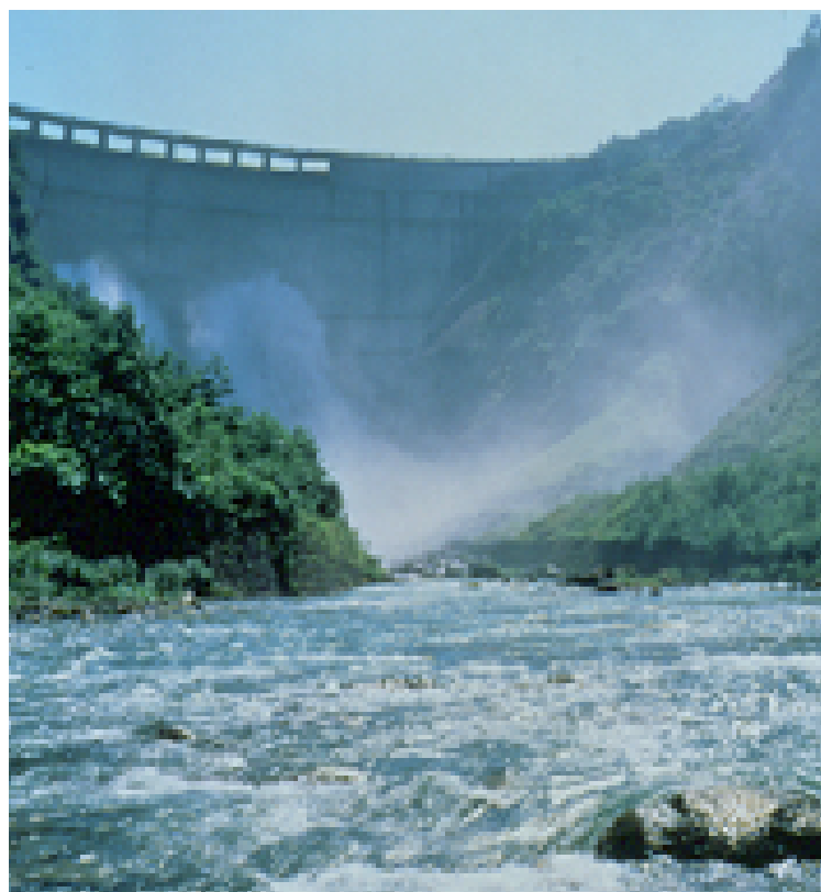
黒部川第四発電所
