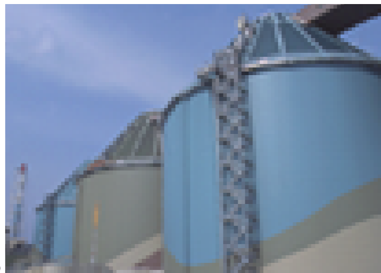
舞鶴発電所 (2004年8月運転開始)
