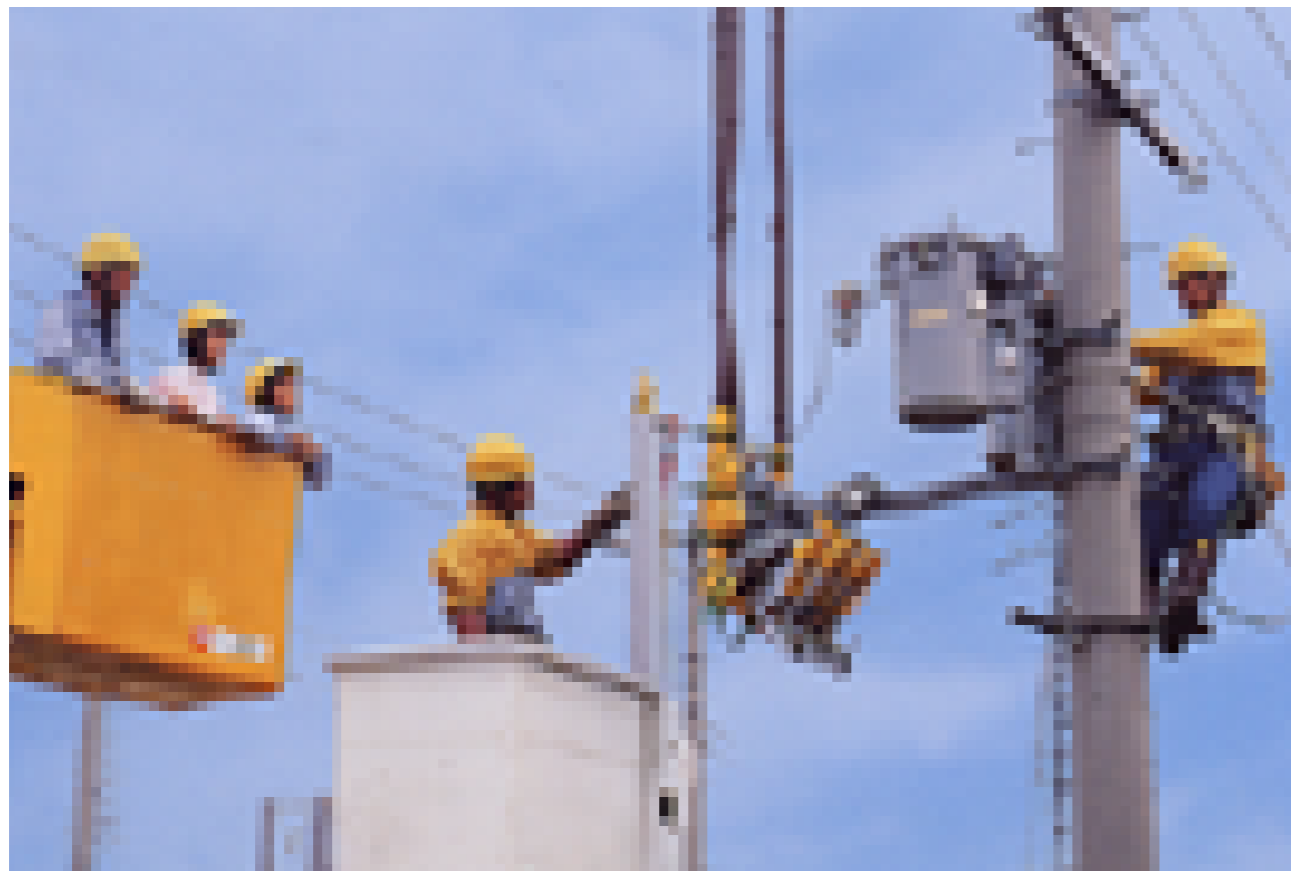
バケット車で配電線作業見学
