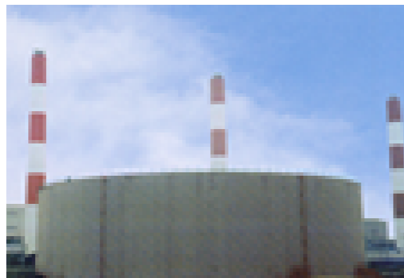
シンガポール/セラヤ第一火力発電所
