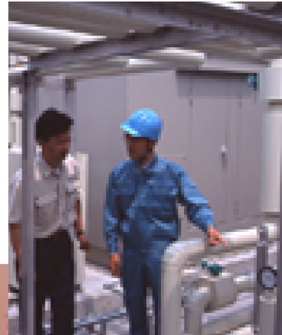
コージェネシステム販売（関電ガス・アンド・コージェネレーション（株））
