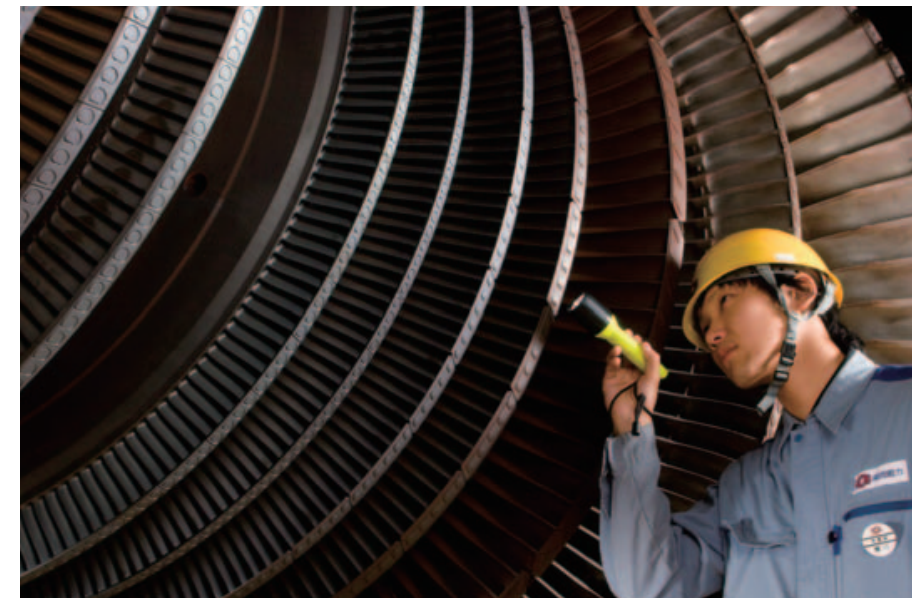
発電所のタービン点検作業
