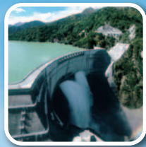
黒部川第四発電所(水力)
