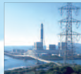
御坊発電所(火力)
