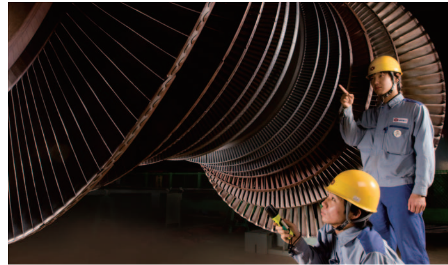
発電所のタービン点検作業
