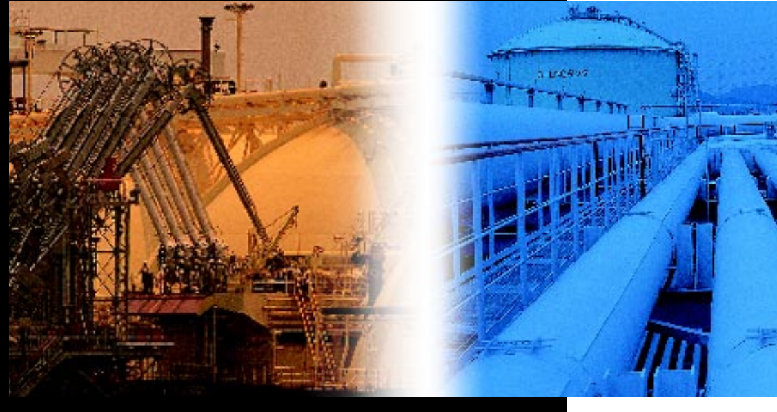
LNG ship and loading arms/Himeji LNG storage facility
