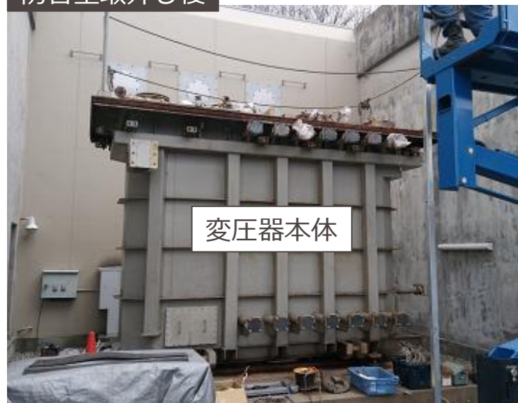
防音壁取外し後
