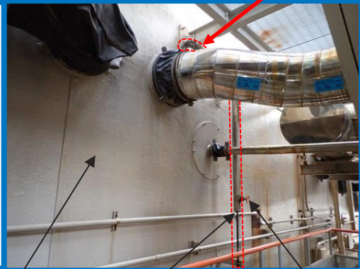
タービン建屋(壁面)
