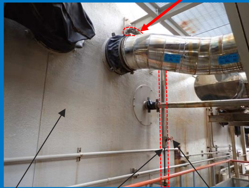
タービン建屋(壁面)
