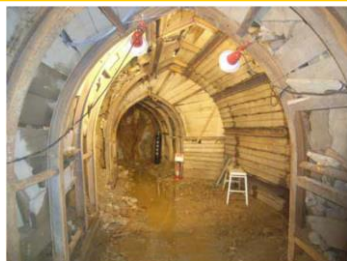
試掘坑調査（イメージ）
