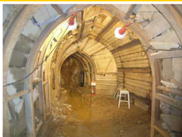
試掘坑調査 (イメージ)
